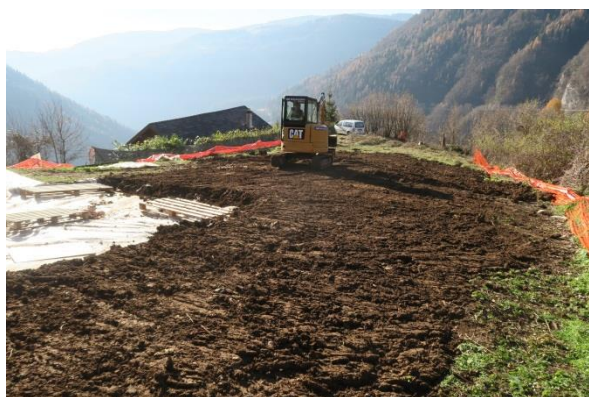
Figura 3. Le operazioni di ripristino in corso in data 01/12/2018
